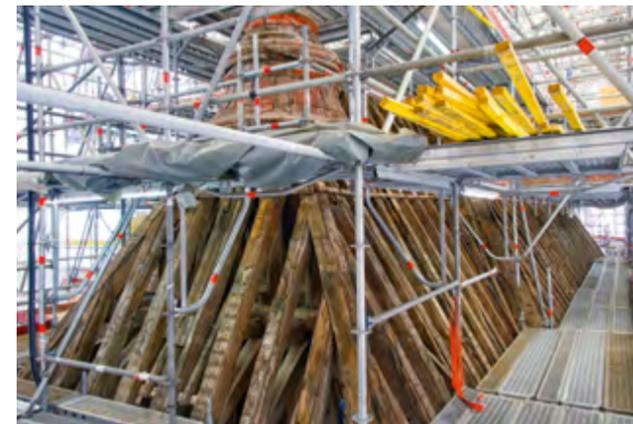
Au cours de la dépose de l'ancienne couverture, l'état de conservation de la charpente s'est avéré extrêmement dégradé, les sablières étant totalement abîmées par les nombreuses infiltrations d'eau pluviale provenant des chéneaux. Un marché complémentaire au lot charpente a dû être engagé pour répondre à ces travaux d'urgence primordiaux, augmentant ainsi le planning des travaux sur la charpente de trois mois.
