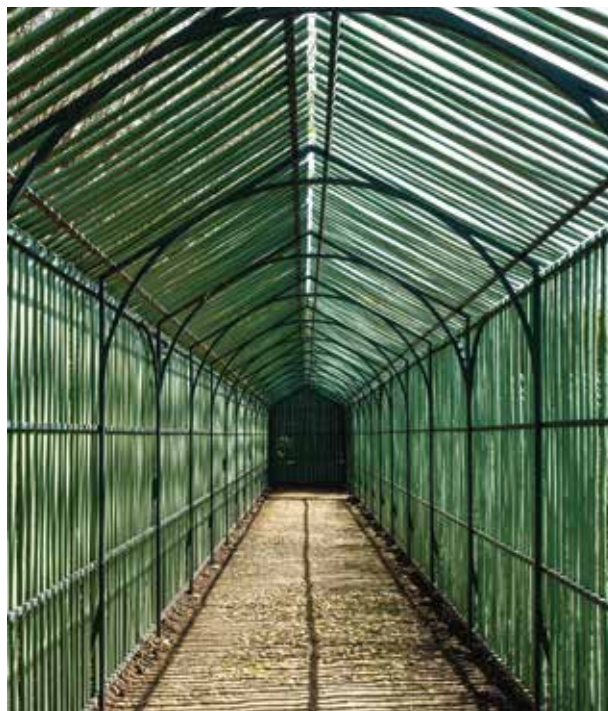
Restored pergola © château de Versailles / T. Garnier
