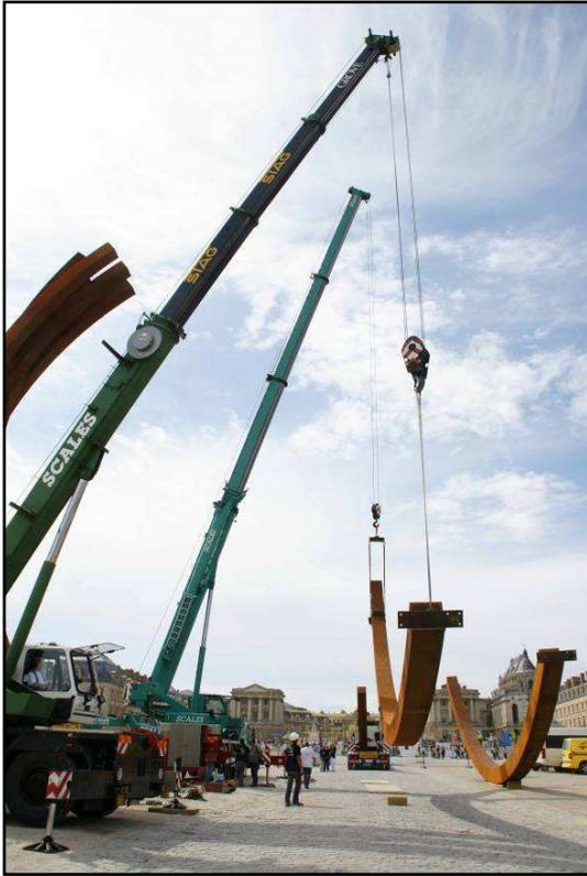
Les Arcs qui encadrent le château sont fixés par boulonnage sur un bâti de deux fois quinze tonnes, lui-même fixé dans le sol par des tiges d'acier de quinze mètres de long. N'oublions pas que chaque arc mesure vingt-deux mètres de haut et que sa base est faite d'une petite plaque soudée percée de douze trous boulonnés sur la structure de base.
